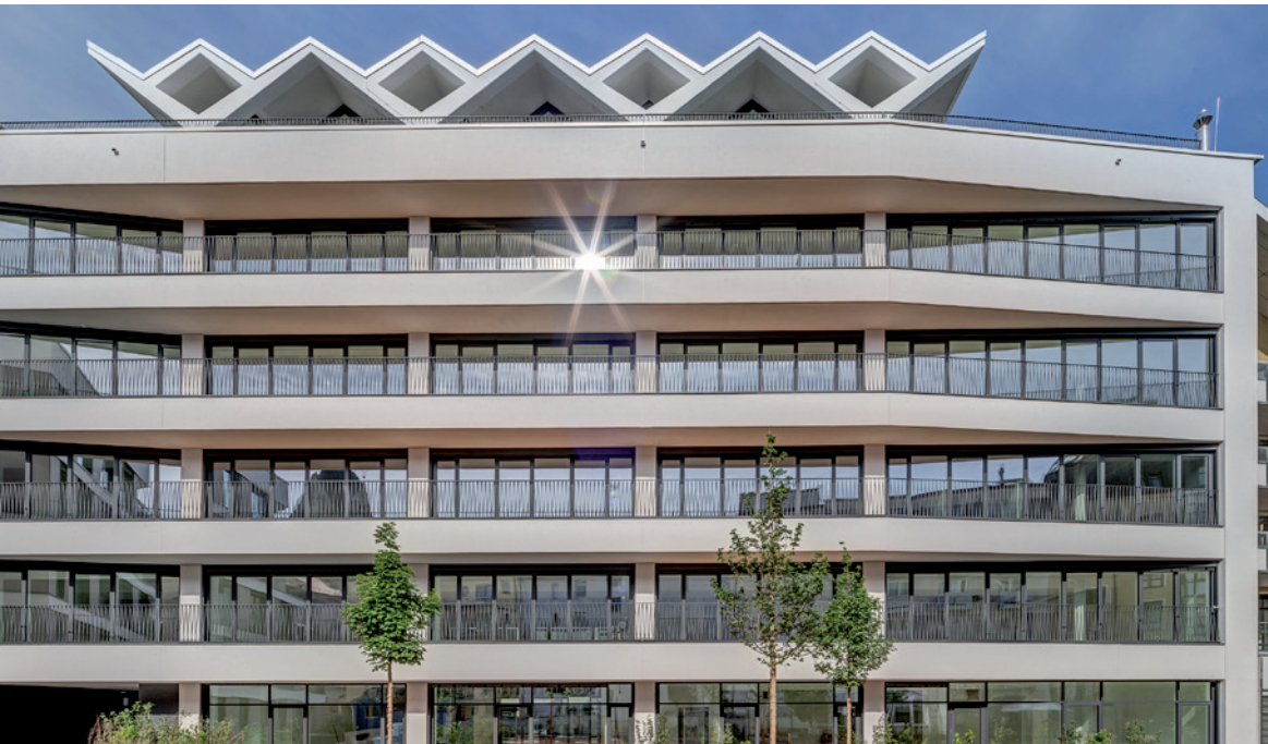
Das Münchner Büro der Kanzlei Weiss Walter Fischer-Zernin befindet sich ganz zentral in der Nähe der St. Anna-Kirche im Lehel, einem charmanten alten Viertel hinter der Staatskanzlei.
